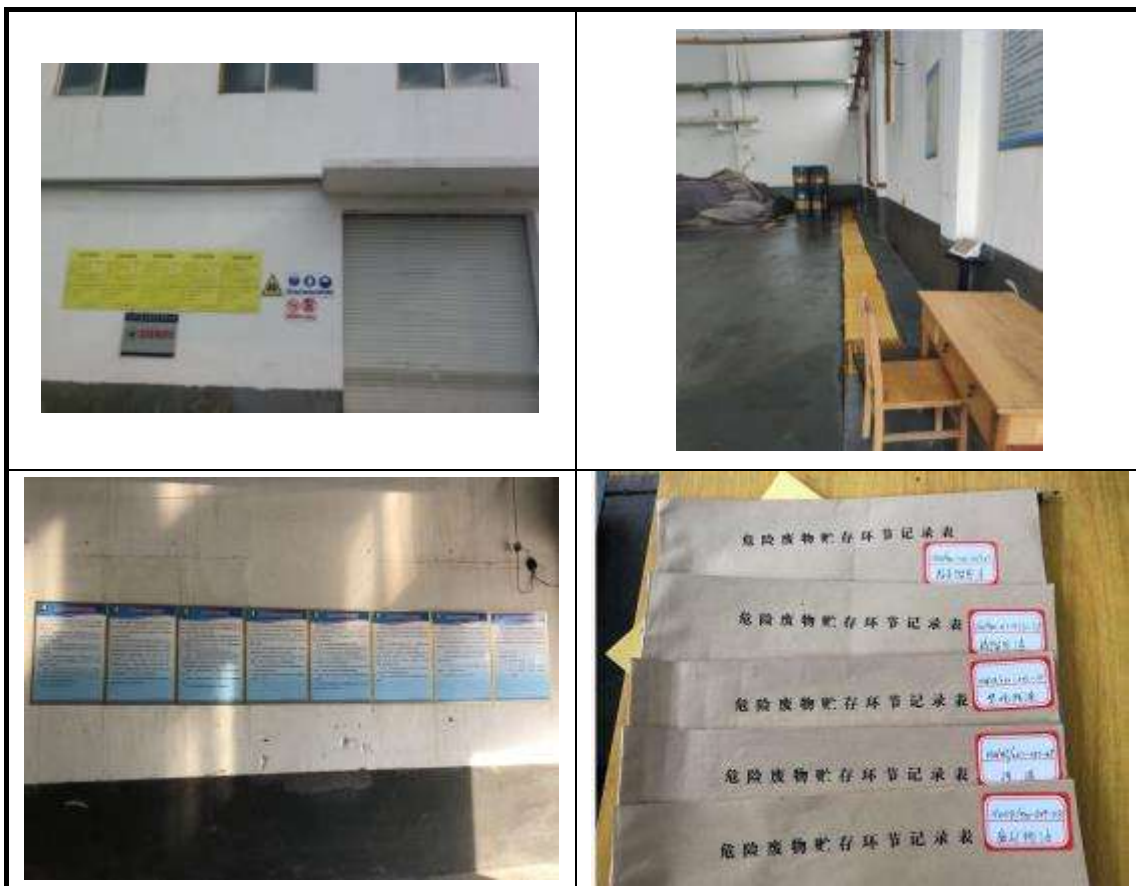
图6.2-14 现有危废库建设实景图
